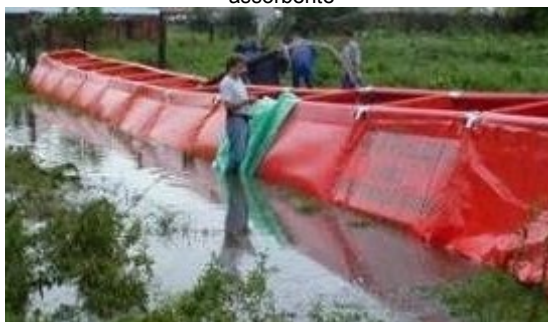
Barriera temporanea antiesondazione riempita ad acqua
