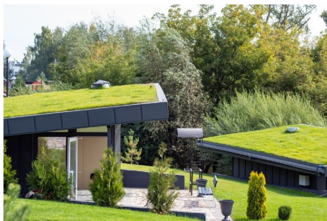
Esempio di tetto verde
