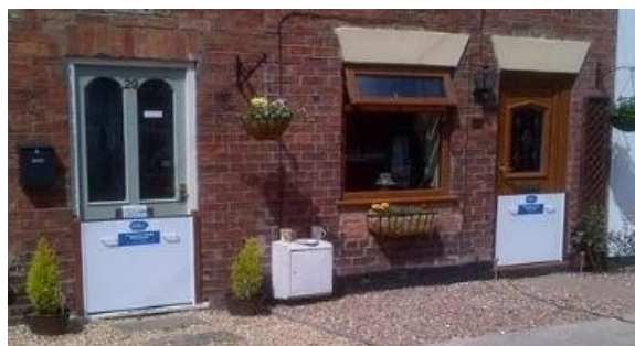
Paratoie manuali a protezione di porte di ingresso
