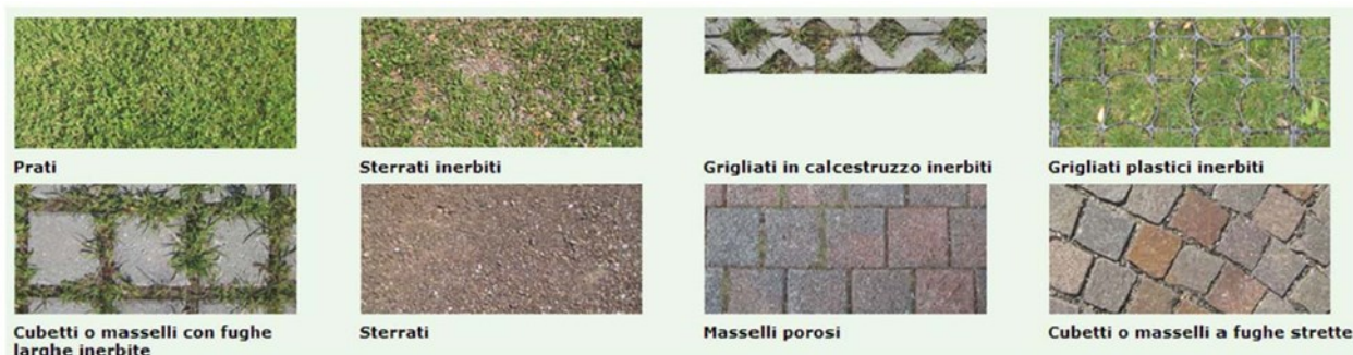
Esempi di pavimentazioni permeabili
